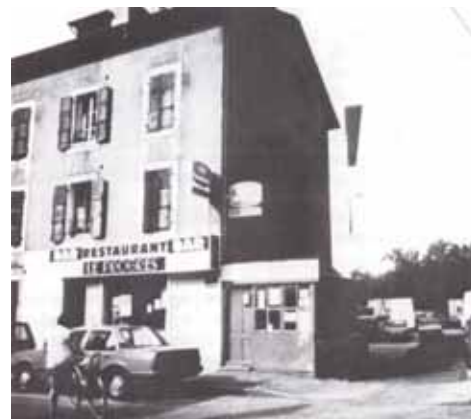
1983 : ouverture de la rue Molière
